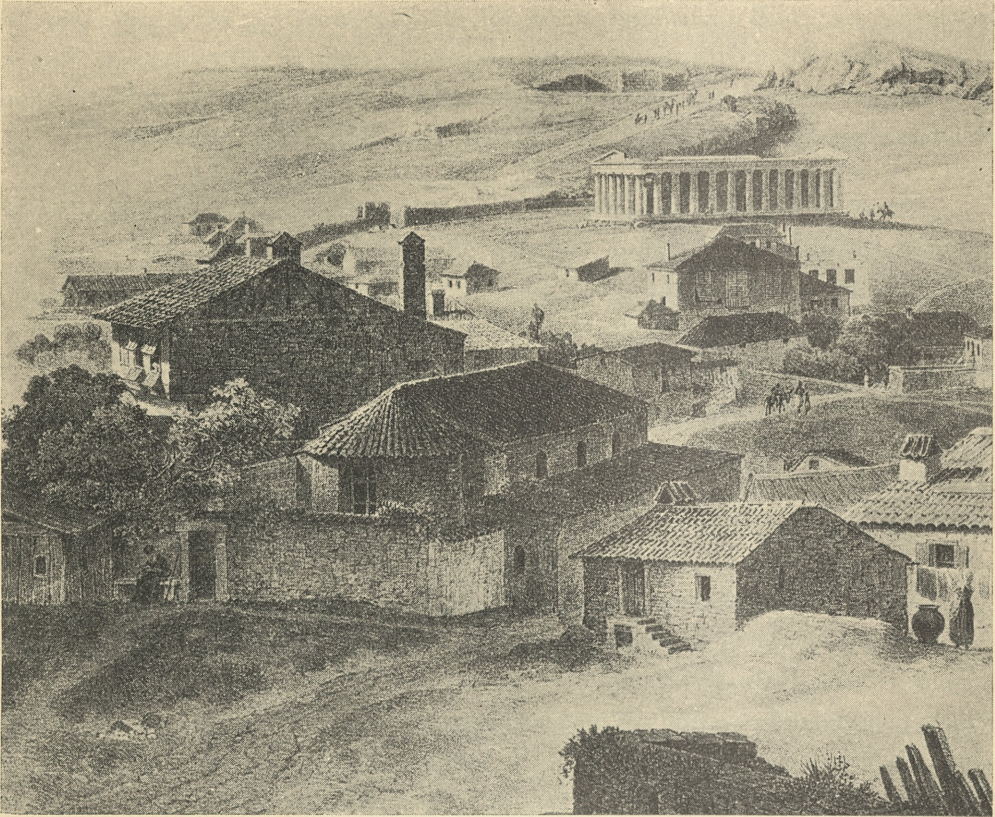
Ὁ Ἅγιος Ἀθανάσιος τοῦ Ψαρῆ, ὅπως ἐσώζετο κατὰ τὰ πρῶτα ἔτη μετὰ τὴν ἀπελευθέρωσιν, προτοῦ κατεδαφισθῆ (Stademann 1835).
