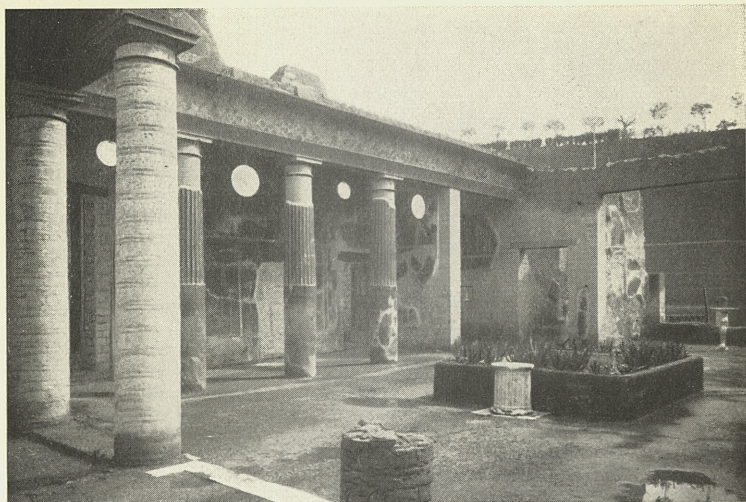
68 - LA "CASA DEL RILIEVO DI TELEFO", : L'ATRIUM
