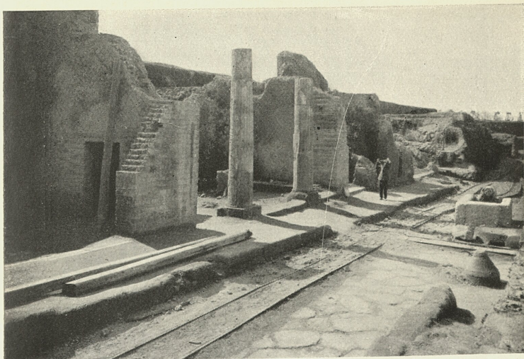
62 - LE GRAND VESTIBULE D'ENTRÉE DE L'INSULA,, ORIENTALE II
