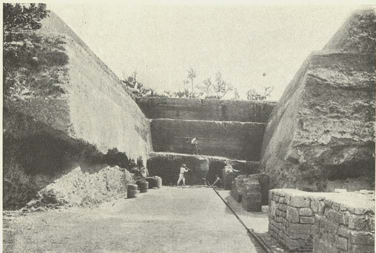
7 - LA PREMIÈRE GRANDE TRANCHÉE
