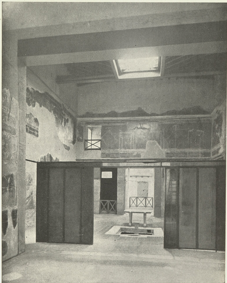
24 - LA "CASA DEL TRAMEZZO DI LEGNO", L'ATRIUM
