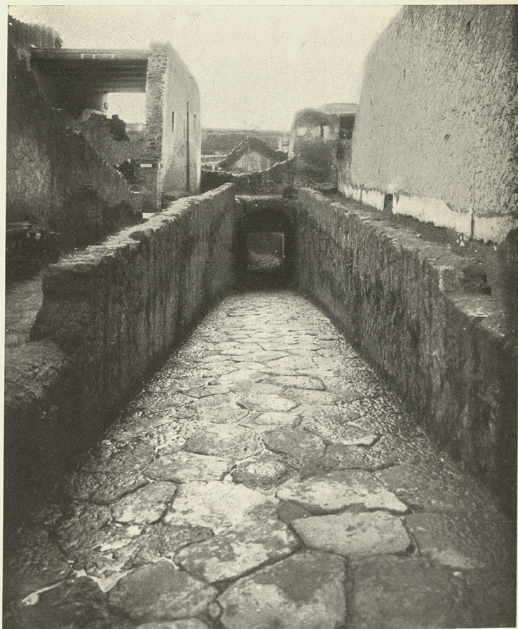
70 - ROUTE QUI MÈNE EN DESCENTE DE LA VILLE À L'ANCIEN PORT DE MER D'HERCULANUM
