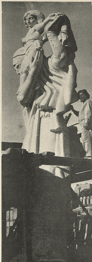
Vierge d'Alsace (Photographie prise en chantier) 1920-22
