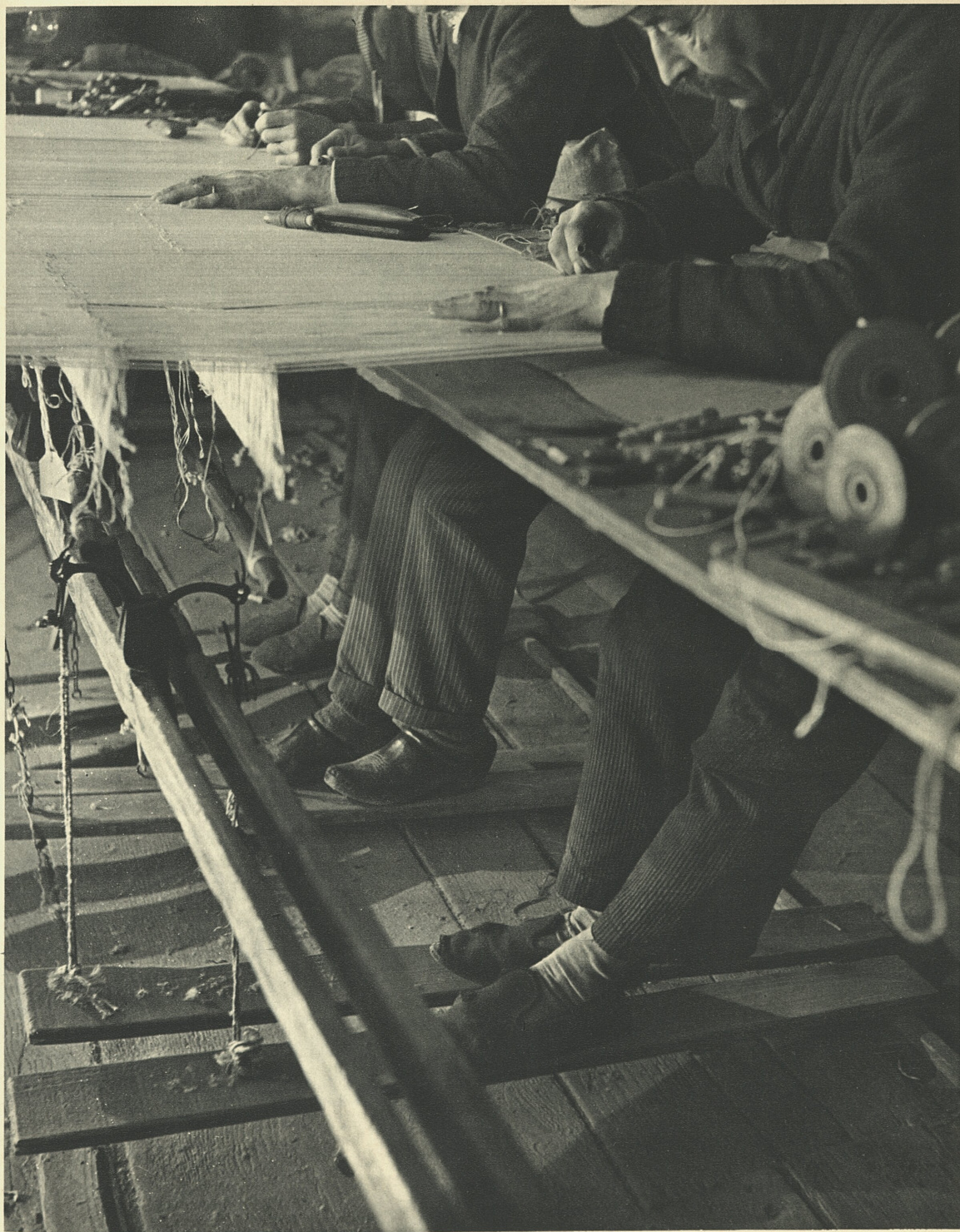
EN BASSE LISSE CE SONT LES JAMBES DE L'EXÉCUTANT QUI SÉPARENT LES FILS PAIRS DES FILS IMPAIRS DE LA CHAÎNE.
