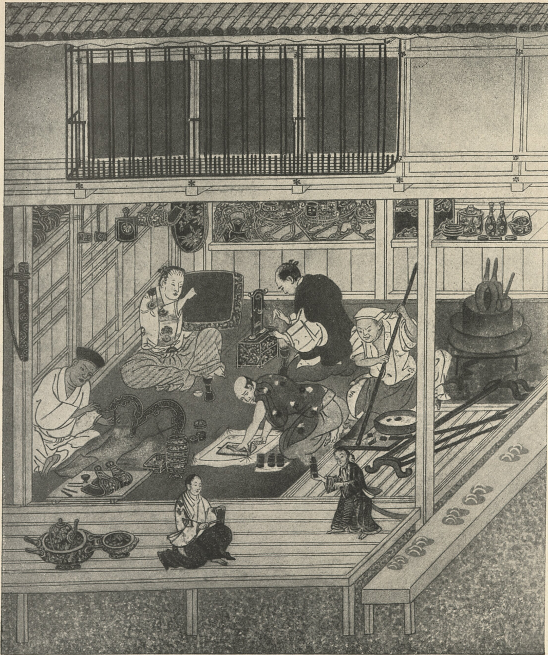
Japanische Lackierer-Werkstatt nach einem Holzschnitt aus dem 17. Jahrh. Man erkennt den Trockenofen, das Schleifen der Hölzer und Lackschichten, die verschiedenen Arbeitsgänge der Lackierung. Die Lackierer haben ihre Schuhe ausgezogen, um möglichst staubfrei zu arbeiten. In der Regel führen sie auf das offene Meer hinaus, wo sie am besten die viele Wochen dauernde Arbeit herzustellen vermochten.
