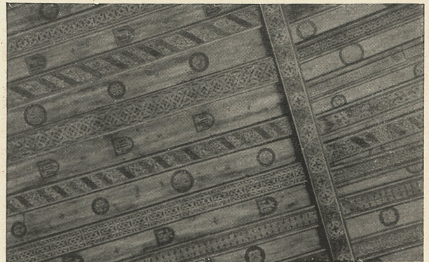
Teil der mittels Schablonen bemalten Balkendecke der Klauskapelle zu Goslar. 12. Jahrhundert.
