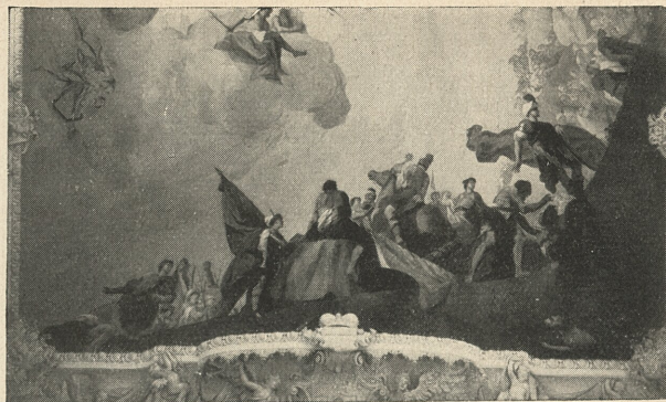
Deckenbild vom Festsaal im Schloß von Schleißheim, das die Decke fortzutauschen versucht, gemalt auf flache Korbbogengewölbe mit hölzerner Unterkonstruktion („falsche Gewölbe“) deren Anfänge durch das weit ausladende Gesimse verdeckt sind. Erst 100 Jahre später gelingt es durch Eisen und Glas, die Decke wirklich dem Licht zu öffnen (s.S. 57 Textbild).
