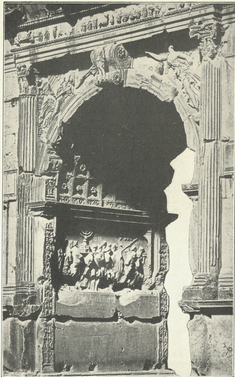
Voûte décorée de caissons à rosaces. A la clef de l'arc, grosse console très ornée entre deux victoires ailées. Partie centrale de l'Arc de Titus, à Rome.
