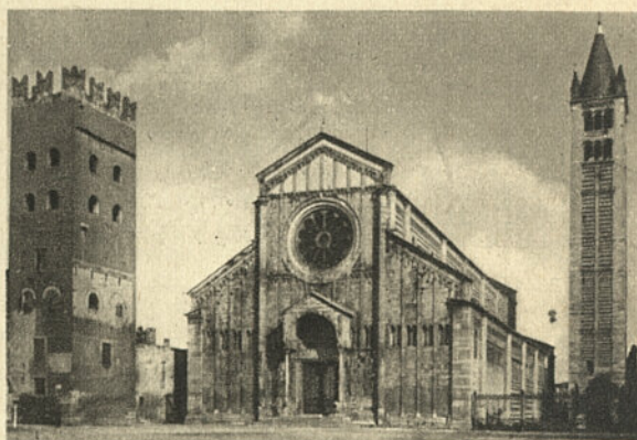
Façade de Saint-Zenon, à Vérone Cl. Alinari
