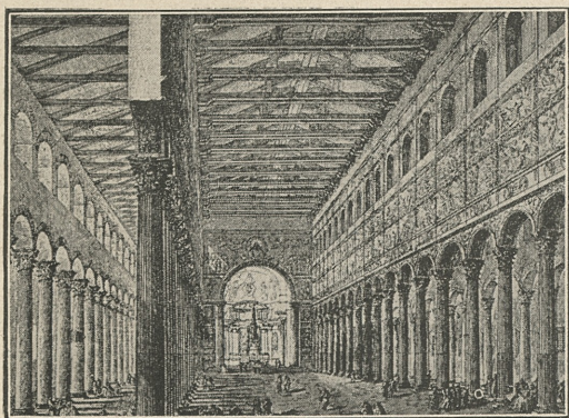
Fig. 1. — Saint-Paul-hors-les-murs, à Rome.
